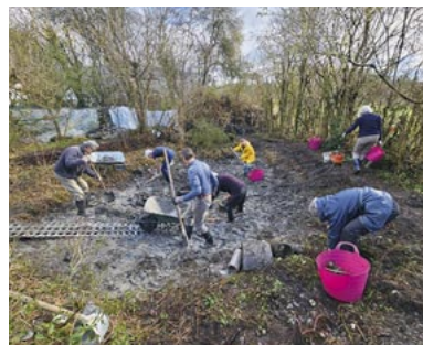
Grosser Einsatz bei der Sanierung des Teichs im Biotop Tannental. Bild: zVg
